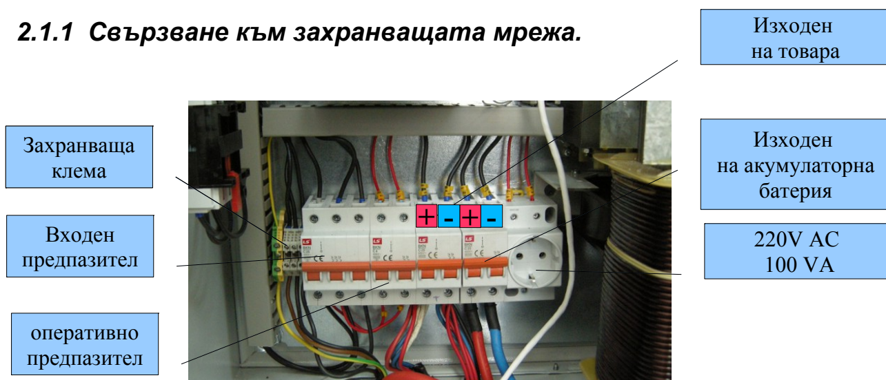
Фиг 2.1. Захранваща клема на AproPower ACC-130/10
